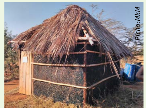
Jokofu asilia kwa ajili ya kuhifadhi mazao ya mboga mboga na matunda mara baada ya kuvuna
